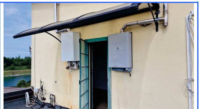
Figura 11 - Accesso al terrazzo dal vano cucina
