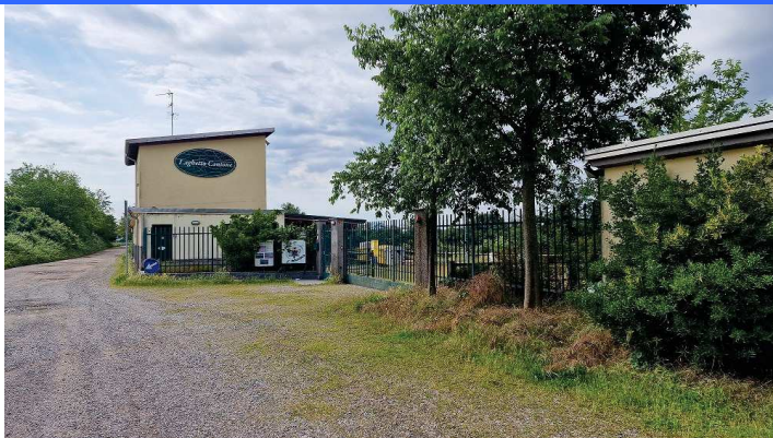
Figura 1 - Ingresso Laghetto Cantone
