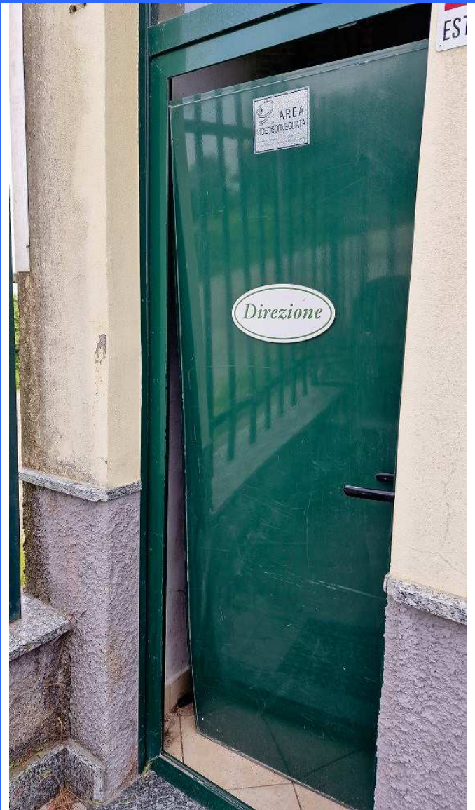
Figura 6 - Porta di accesso all'Ufficio di Direzione
