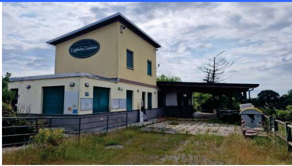
Figura 5 - Vista di insieme fabbricato principale
