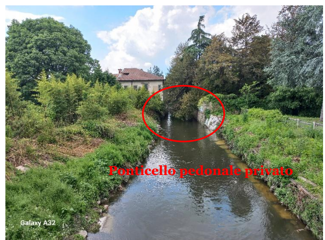
Ponte hotel dei Giardini, foto da ponte parco di via Roma
